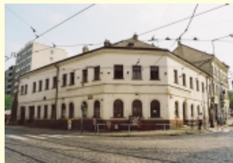
Budova budoucí obchodní kanceláře MOS pro Prahu 4 před zahájením rekonstrukce
