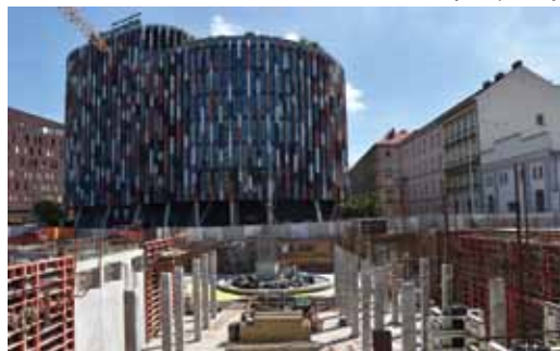
Budování prvního podzemního podlaží – červen 2016
