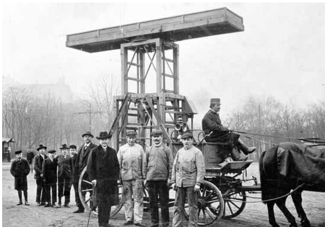
Montovní vůz pro stavbu a údržbu trolejového vedení elektrické dráhy před Výstavištěm v Holešovicích (1898)
