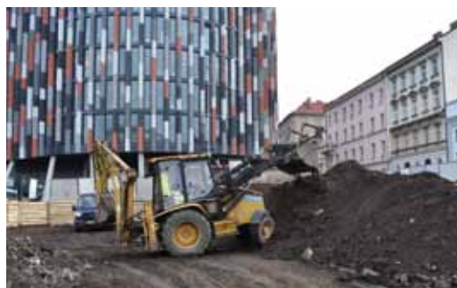
Budování základů rozvodny – únor 2016
