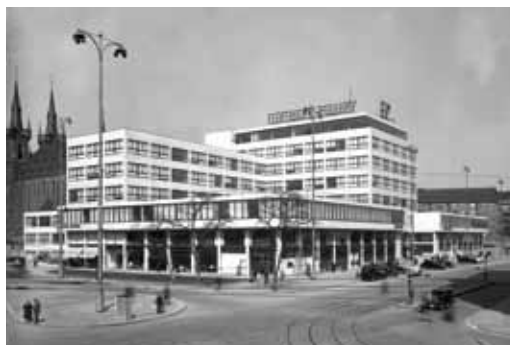
Ústřední budova Elektrických podniků hl. města Prahy po dokončení v roce 1934
