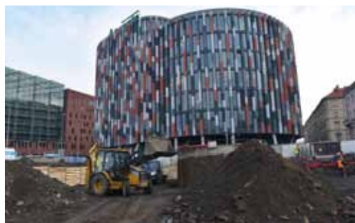
Staveniště TR Karlín v těsném sousedství moderní budovy Kooperativy
