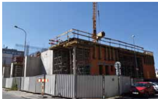
Pohled na budoucí vstup do rozvodny – srpen 2016
