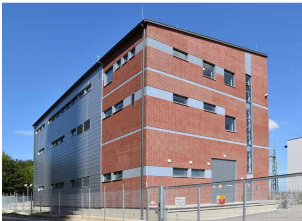
Nová rozvodna Třeboradice – budova společných provozů
