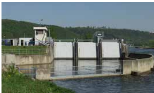
Soustroj modřanské elektrárny se nachází asi šest metrů pod hladinou řeky.
