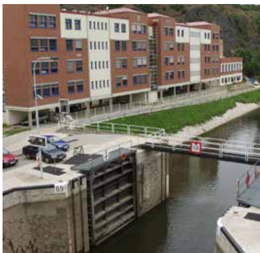
Podbaba: Při proplouvání lodí se hladina v plavebních komorách zvedne o pět metrů. Při povodních v roce 2002 byla ještě o dalších sedm metrů výše...
