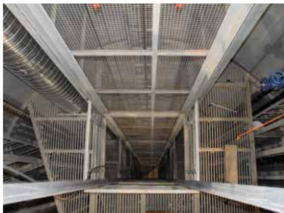
Vyústění z kabelového tunelu Karlín do suterénu rozvodny - 38 m hluboká šachta
