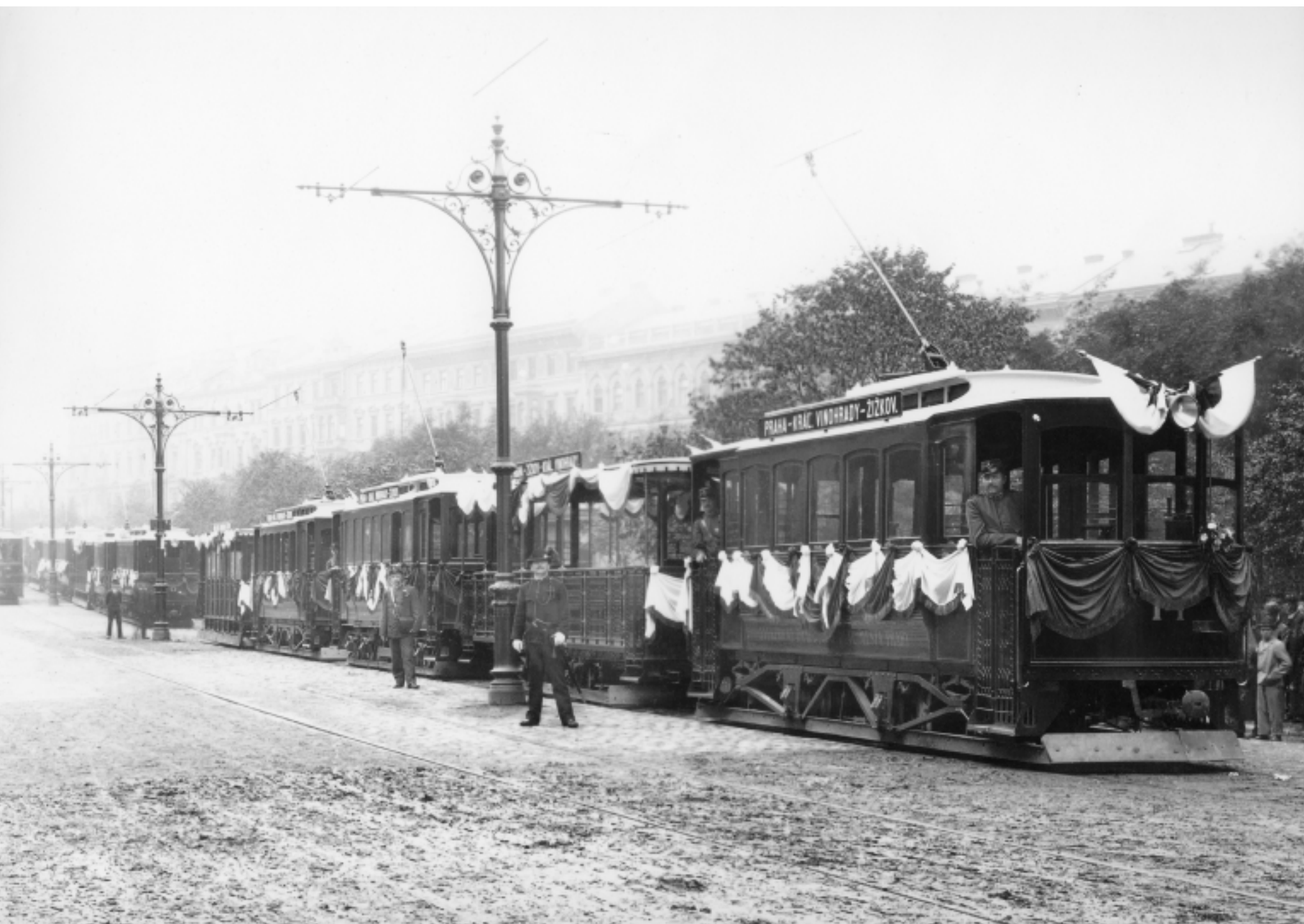
Prvním počinem nově založených Elektrických podniků královského hlavního města Prahy bylo zaběhání provozu na trati elektrické dráhy Praha – Žižkov – Král. Vinohrady 18. září 1897.
