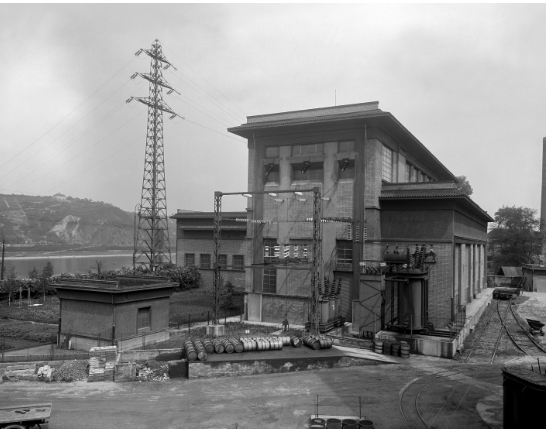
Transformační stanice 110/22 kV Sever v areálu holešovické elektrárny sloužila v letech 1926–1980; byla prvním zařízením svého typu v Praze.
