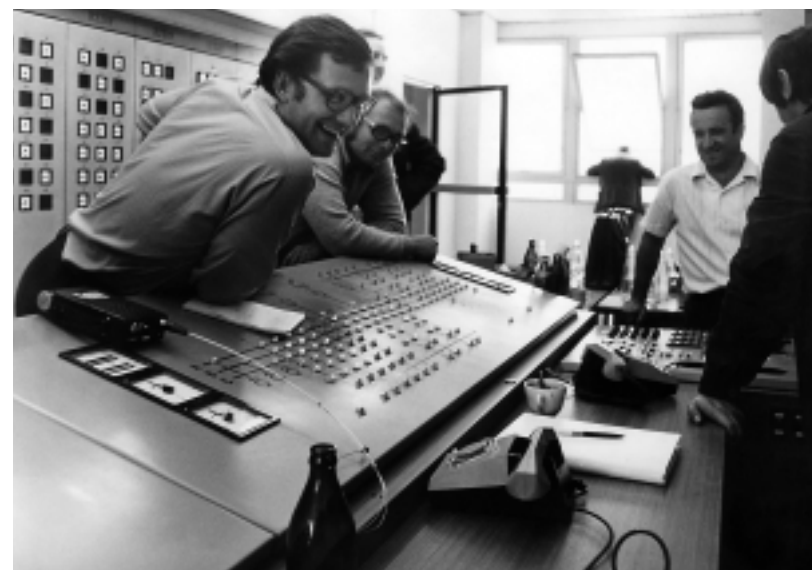
Velín transformovny a rozvodny 110/22 kV Chodov při zahájení provozu v roce 1979
