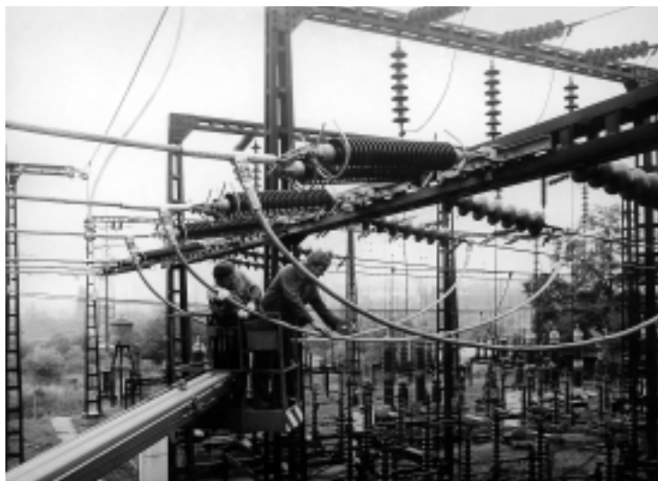
Rozvodna 110 kV Chodov
