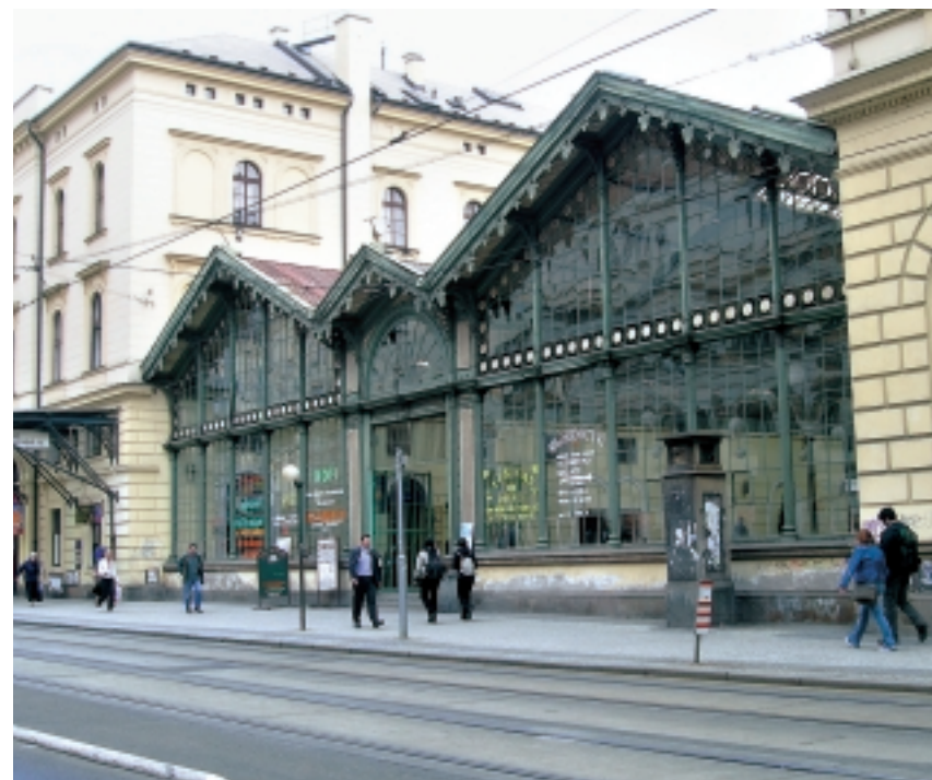
Před Masarykovým nádražím stojí dávno nefunkční skříň elektrických hodin – vzácný pozůstatek meziválečné elektrické rozvodné sítě.
