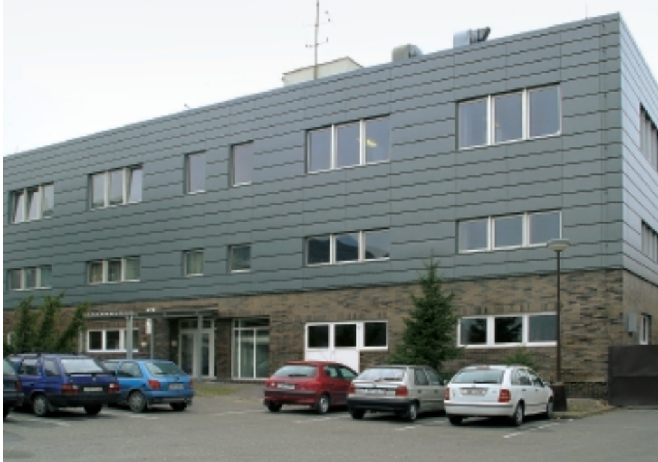
Transformovna a rozvodna 110/22 kV Pražáčka v roce 2003
