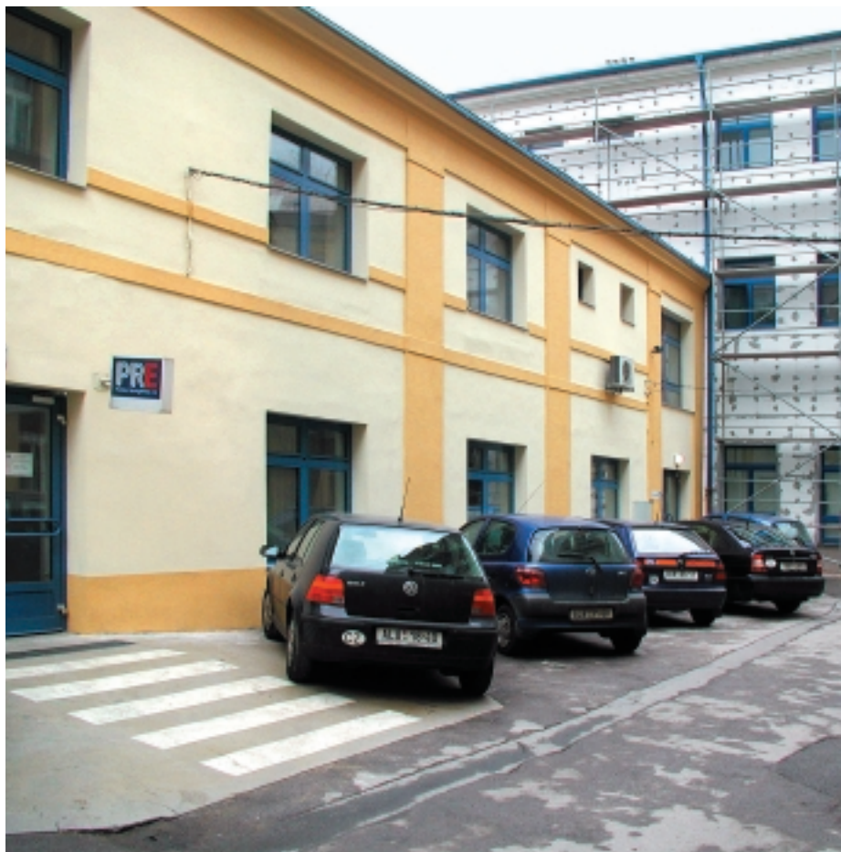
Objekt bývalé Provozní správy Jih v Sokolské ulici v roce 2005. V letech 1924–1952 tu bývala transformovna a rozvodna 22/3 kV. V roce 2007 byla zahájena přestavba objektu.
