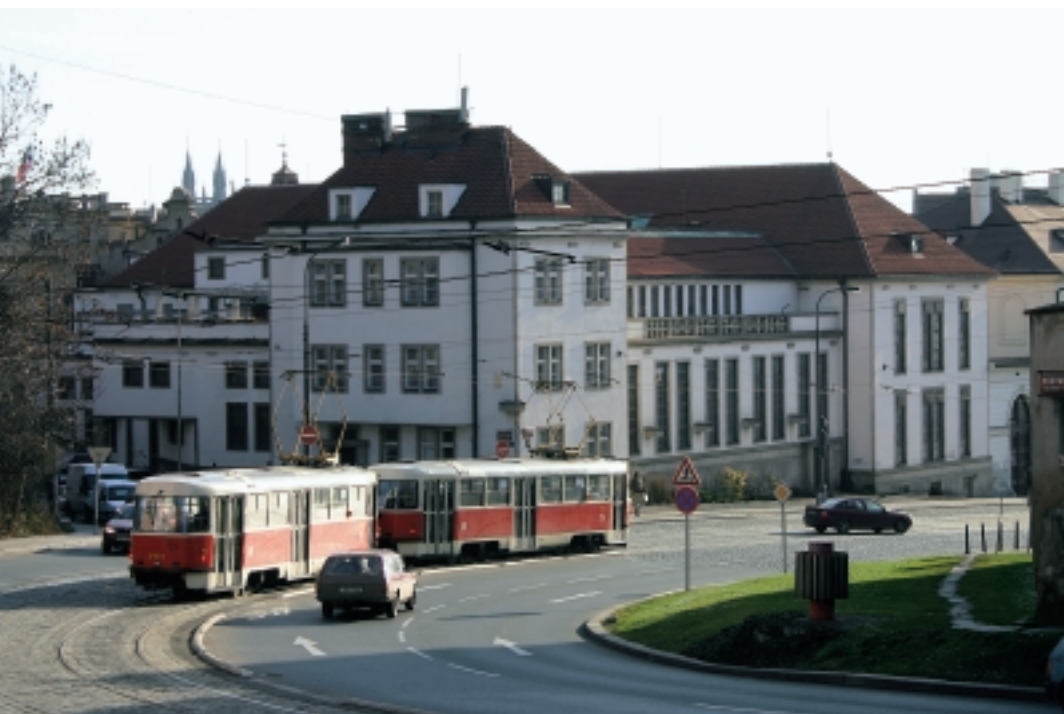
Zengrova transformační stanice na Klárově na počátku roku 2007
