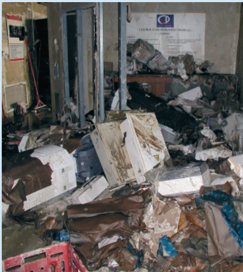
Pracoviště v přízemí budovy společnosti Cejchovna elektroměrů Praha, a.s., zničené při povodni
