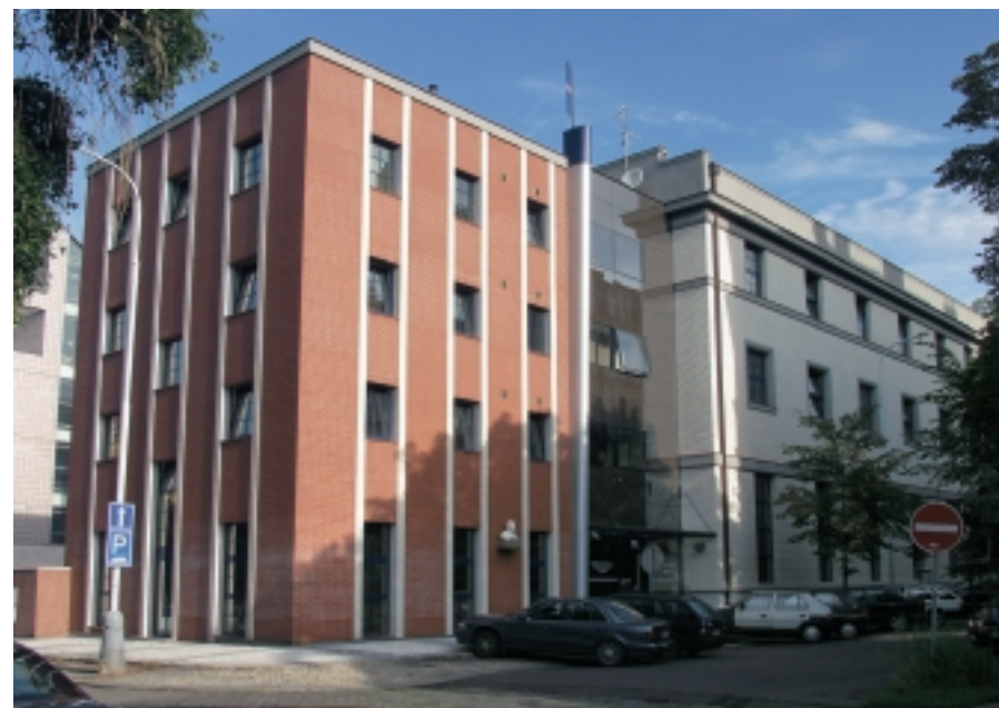
Bývalá transformovna a rozvodna 22/3 kV v Nitranské ulici z roku 1924 slouží po rekonstrukci od roku 2003 jako pracoviště řízení sítě 22 kV a 110 kV.
