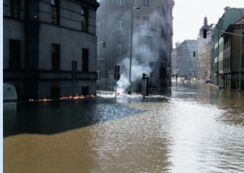
Hořící kabely vysokého napětí v zaplavené oblasti centra města
