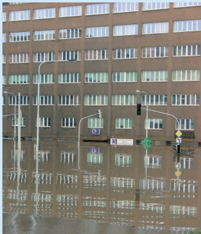
Zaplavená Partyzánská ulice – budova společnosti Cejchovna elektroměrů Praha, a.s.
