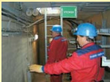
Uvnitř šachty kabelového tunelu
