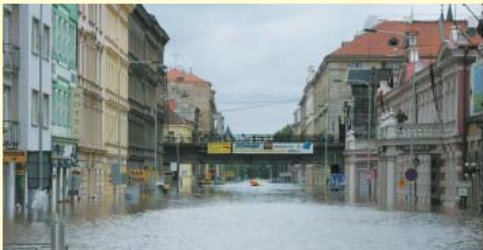
Při povodních v létě 2002 zaplavil vodní živel i naše „suchozemské“ kabelové tunely. Přesto kabely v nich odolaly a vedly elektrický proud spolehlivě i v takovýchto nestandardních podmínkách.
