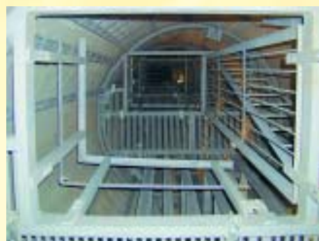
Sestup po žebřících do hloubky 30 metrů
