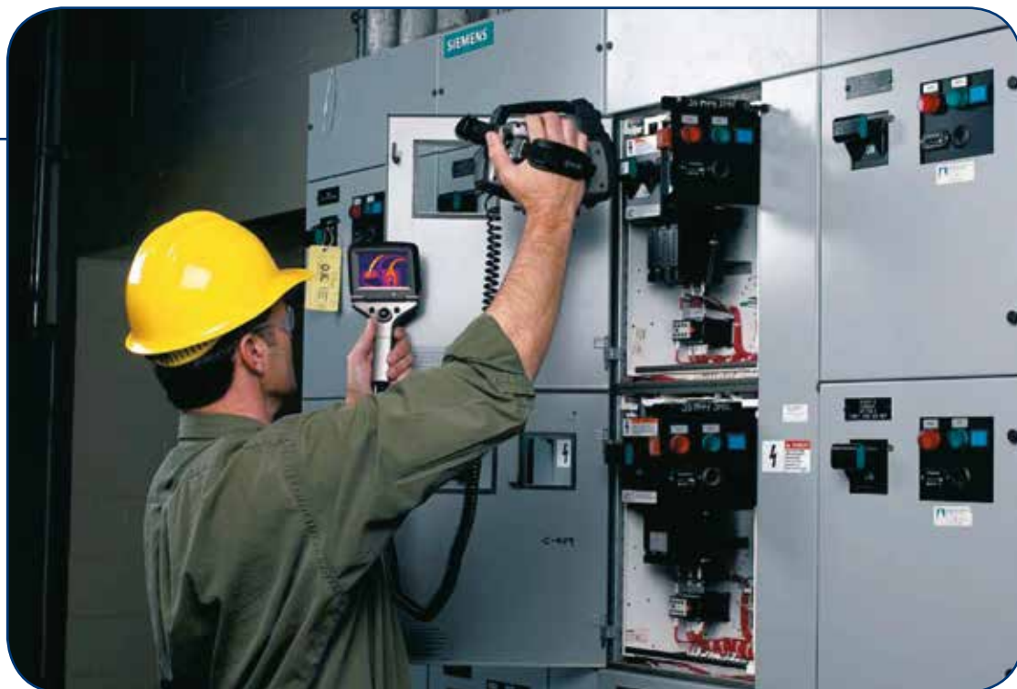
Ukázka měření termovizní kamerou
